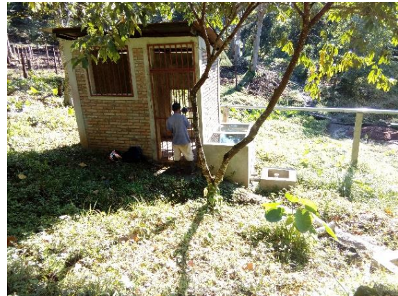
La Bendición Pumphouse – November 2019
